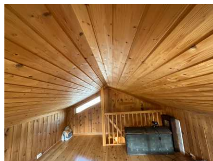
Utsnitt gjenbygd takkonstruksjon.
