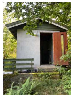
Renseanlegg plassert i hus på nordvestsiden av boligen.
