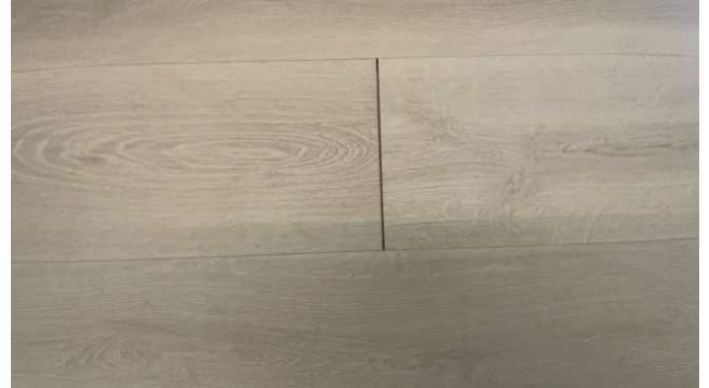
Eksempel på gliper i laminat
