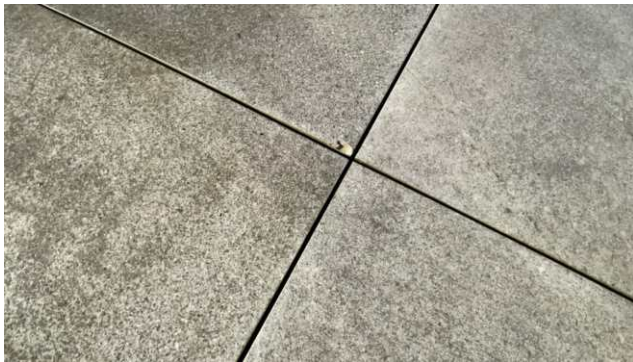
Enkelte steder påvist avskalling i flisheller
