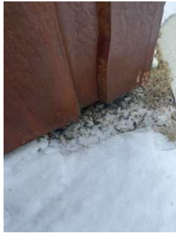
Panel noe nærme terreng på bakside. (Ingen tegn til skader).
