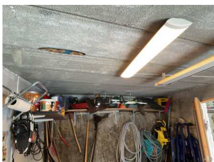
Leca elemter i tak og fjellvegg i bakkant.
