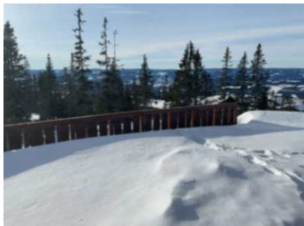
Rekkverk over carport og bod.
