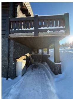
Forstøtningsmurer under veranda.
