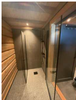
Ikke fuktsikker overflate i våtsonen.
