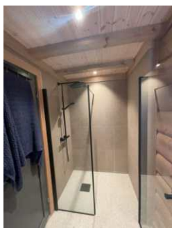
Ikke fuktsikker overflate i våtsonen.
