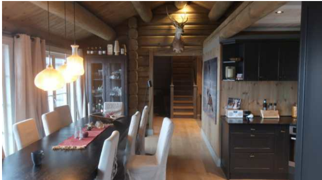
Beiset tømmervegger, himling med åser og parkettgulv
