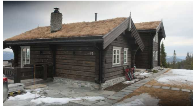
Pipe, forblendet over tak.
