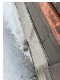
Utenfor teknisk rom/smørebod.
