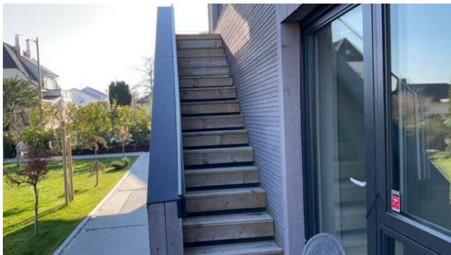
Trapp til balkong.
