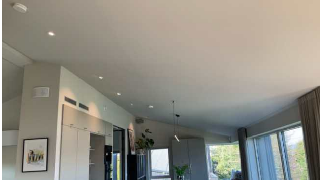
Takkonstruksjon kledd under på innside.
