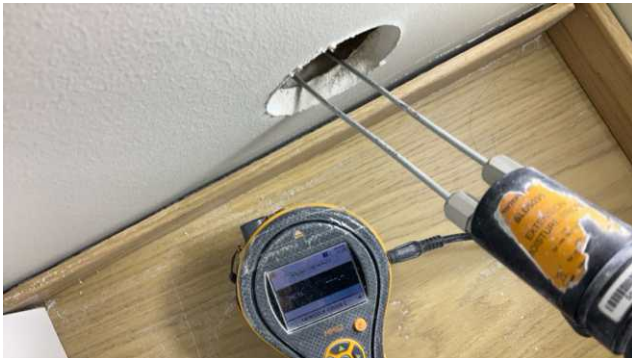
Fuktsøkt i påforet yttervegg uten unormale forhold,
