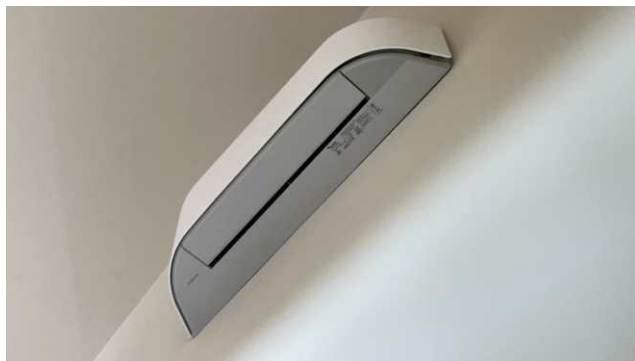
Varmepumpe innedel.
