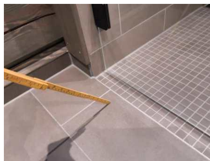
Bom/hullyd på flis registrert.
