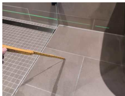
Bom/hulld på flis registrert.
