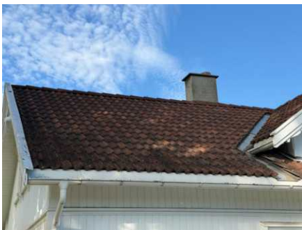
Taktekking sydvest side
