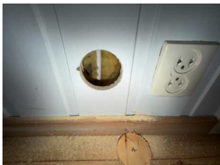
Hulltaking i tilstøtende gang
