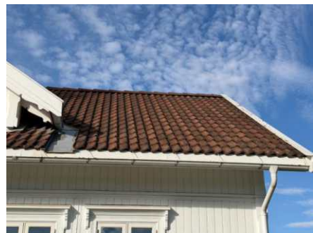
Taktekking sydvest side
