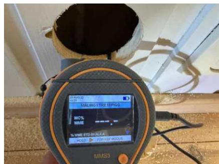
Hulltaking i tilstøtende gang
