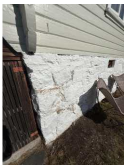
Noe lokal utbedringer/vedlikehold av bygningen grunnmur.
