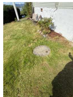
Borrehull til borrevann ligger syd for bygningen.
