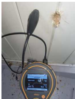
Utført kontroll i tiliggende konstruksjon - Fuktmåling
