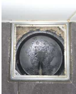
Tettesjiktets tilslutning til sluk - Hjelpesluk bad
