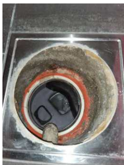
Tettesjiktets tilslutning til sluk - Hovedsluk bad
