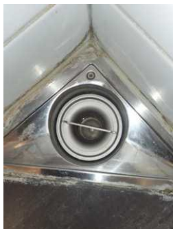
Tettesjiktets tilslutning til sluk - Sluk bad
