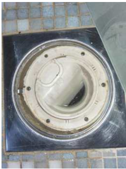
Tettesjiktets tilslutning til sluk - Sluk bad
