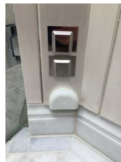
Lekkasjesikring, vannskap og innebygde blandebatteri.
