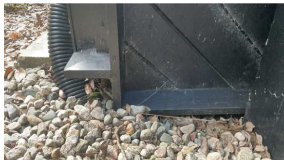
Kledning nært terreng.
