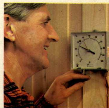
Tankmåler som til enhver tid viser beholdningen på tanken.
