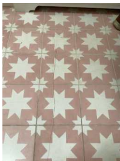
Sprekk i fliser og riss i fuger i entre.
