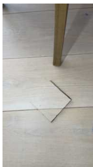
Sprekk i fliser og riss i fuger i entre.
