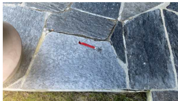
Løsnede fliser.
