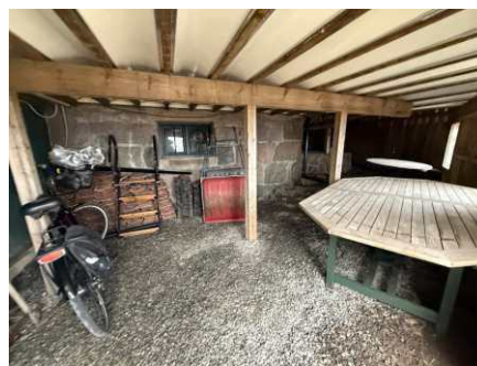
Oppbevaringsplass under terrasse.
