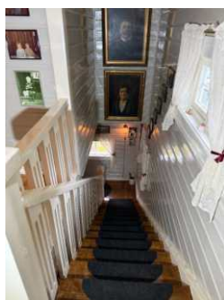
Rekkverk øvre del av trappen under 90 cm og det anbefales håndløper i trappeløpet.
