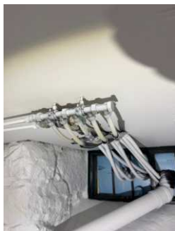
Fordelerstokk for rør i rør system i kjelleretasje.
