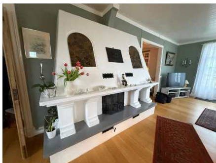
Ildfast plate på gulv anbefales etablert.
