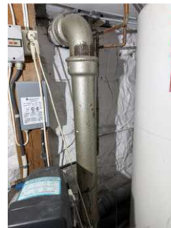
Eldre støpejernsrør observert i kjeller.
