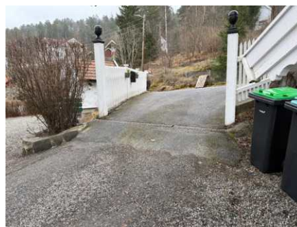
Det er lagt ned et akodren ved innkjøring.
