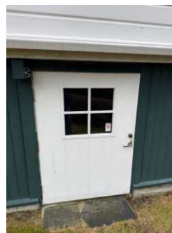
Dør til oppbevaringsplass under innglasset stue.
