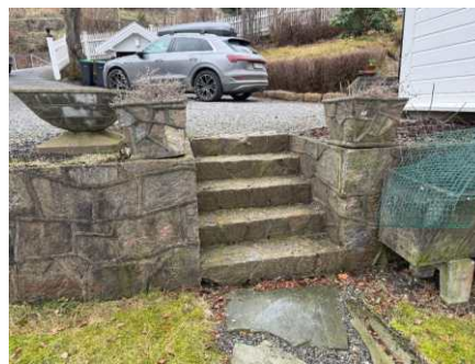
Støttemur ved trapp mot nord.
