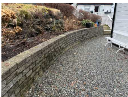
Støttemur ved adkomst mot øst.
