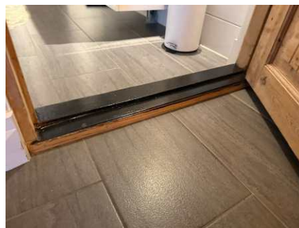
Ikke mulig å verifisere membranoppkant ved dørterskel uten fysiske inngrep.
