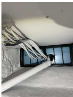
Eldre vinduer fra byggeåret i kjeller.
