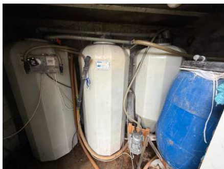
Biovac anlegg i egen frittliggende.
