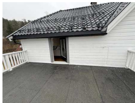
Merk kort gjenværende brukstid på takpapp.
