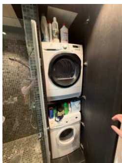
Nisje til vaskemaskin og tørketrommel.
