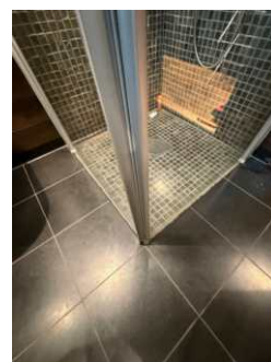
Badet har nedsenket gulv i dusjsonen.
