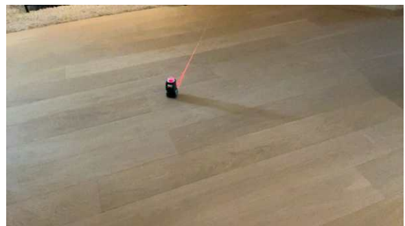
Skjevheter i gulvene er innenfor gitte krav i stuen i underetasjen.
