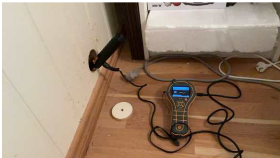
Ingen unormale forhold i vegg mellom soverommet og vaskerommet.
