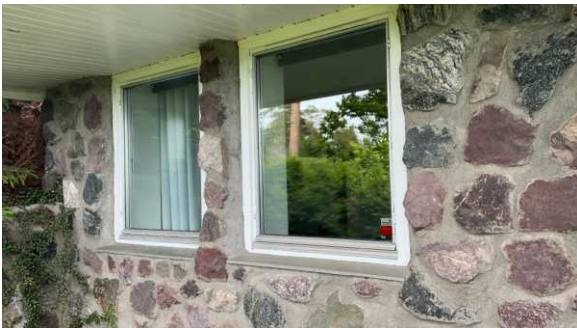
Hovedsakelig vinduer fra byggeåret.
