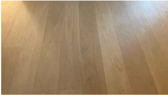
Nytt parkettgolv i stuen i underetasjen
