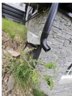
Synlig knotteplast på hjørnet og 'hylle' for skiferforblending.
