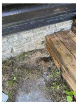
Synlig betongkant som 'hylle' for skiferforblending. Dette er ved trapp inn til kjøkken, likt som på hjørnet.
