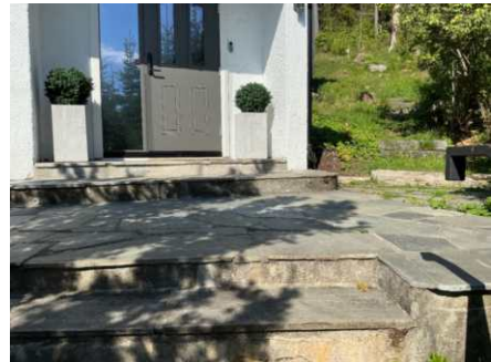
Støpte trapper og repos belagt med skifer.
