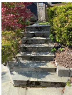
Støpte trapper og repos belagt med skifer.
