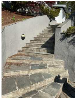
Støpte trapper og repos belagt med skifer.
