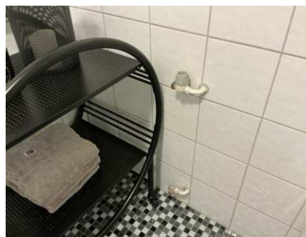
Usikre gjennomføringer
