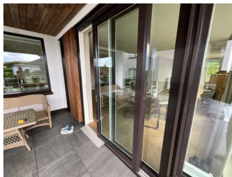
Skyvedør til terrasse.
