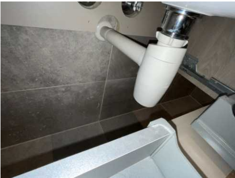
Røropplegg under håndvask, bad (tilkomst fra gsng)
