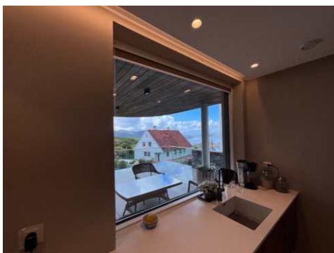
Stort fastkarmsvindu på kjøkken.
