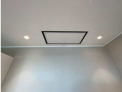
Ventilasjonsavtrekk i himling.
