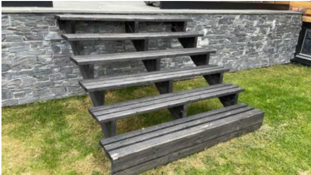
Msneglende rekkverk på trapp
