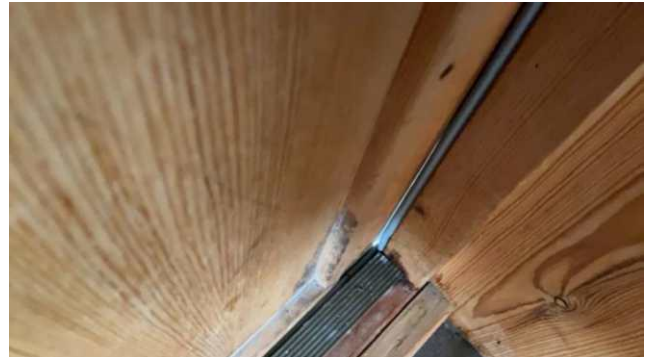
Utettheter overgang karm og dør blad
