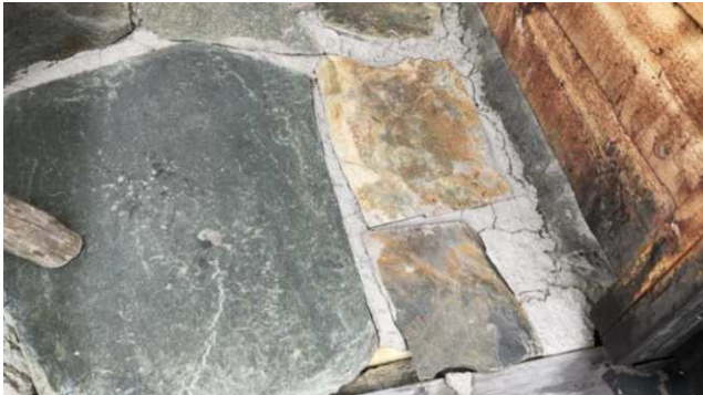
Steiner er løse og med sprekk i fuger
