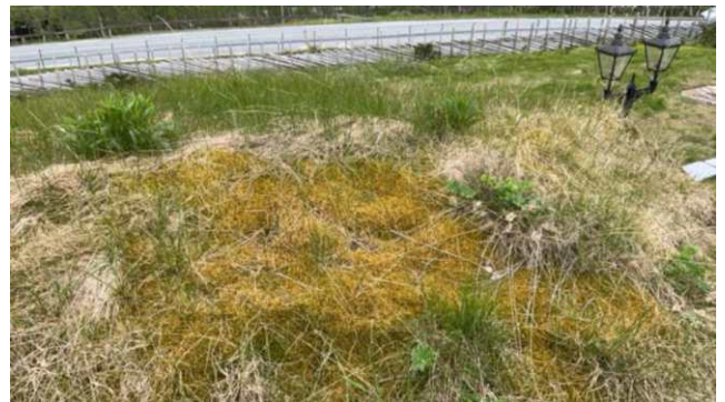
Mose på torv og manglende vedlikehold
