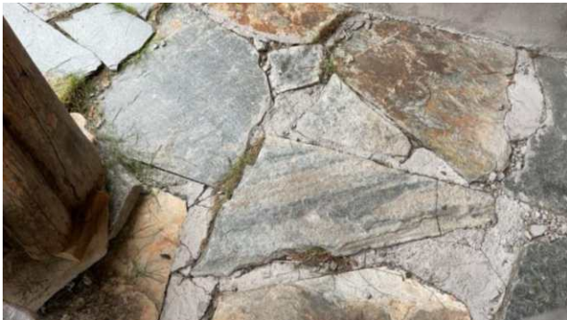
Steiner er løse og med sprekk i fuger
