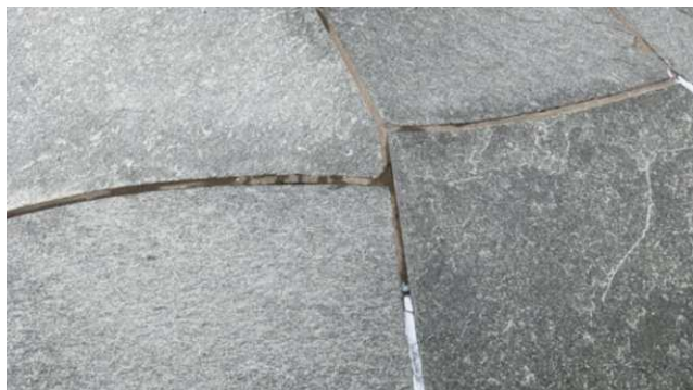
Enkelte fuger er lokalt utbedret
