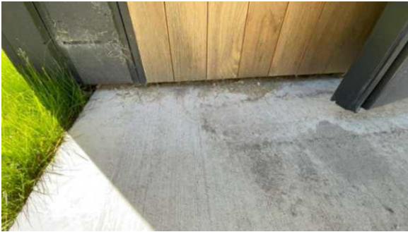
Kort avstand fra terreng til kledning.
