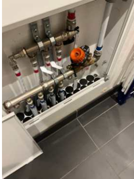
Samlestokk for radiatorrør montert i vaskerom
