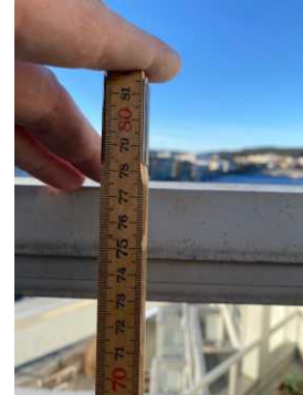
Høyde på rekkverk på veranda.
