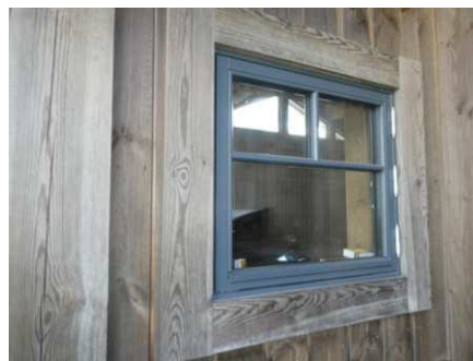
Vindu med utenpåliggende avtagbare sprosser.
