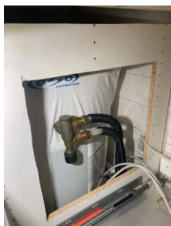
Varmtvannstank innebygget i kjøkkeninnredning.
