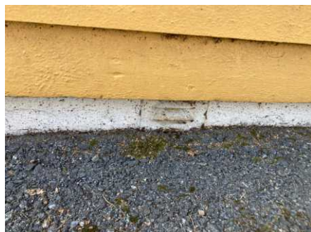
Lufteventil i grunnmur.
