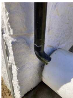
Taknedløp avsluttet ved grunnmur.
