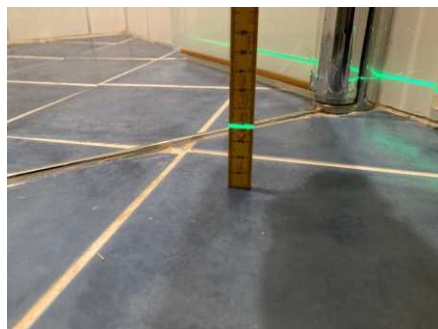
Måling av fallforhold med linjelaser.
