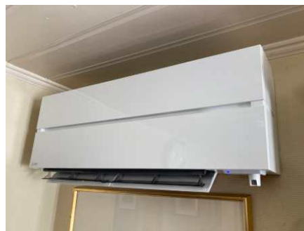
Varmepumpens innedel.
