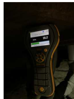
Fuktmåling i stubbeloft/bjelkelag i krypkjelleren
