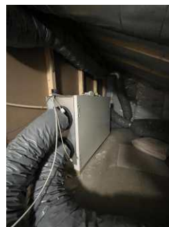
Balansert anlegg plassert på kryploft
