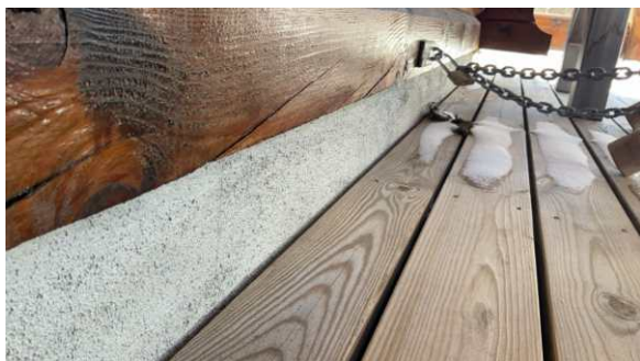
Stedvis utvendig puss på ringmur.
