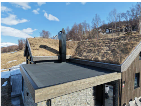
Tak tilbygg tekket med papp.
