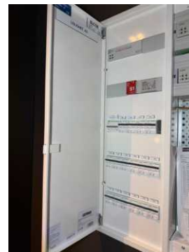
Automatsikringer med skap i hovedsoverom.
