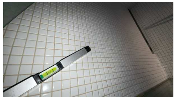
Fallforhold målt i retning sluk.
