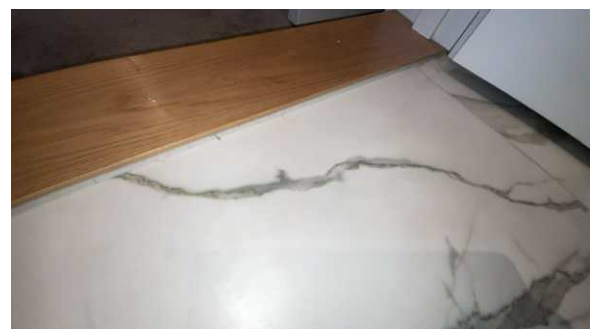
Overgang ved dørterskel.
