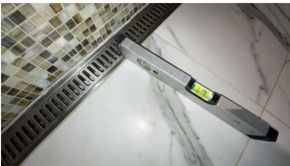
Fallforhold målt i retning sluk.
