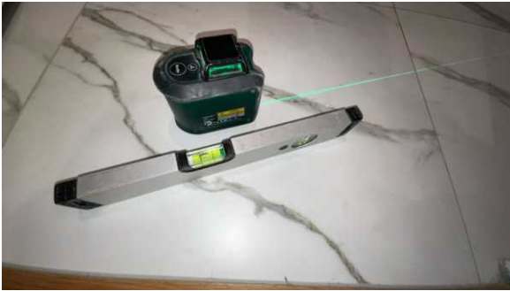
Fallforhold målt i retning sluk.
