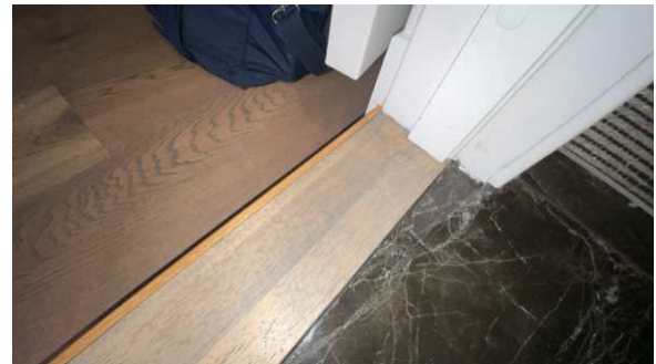
Luftespalte under dørrbladet.
