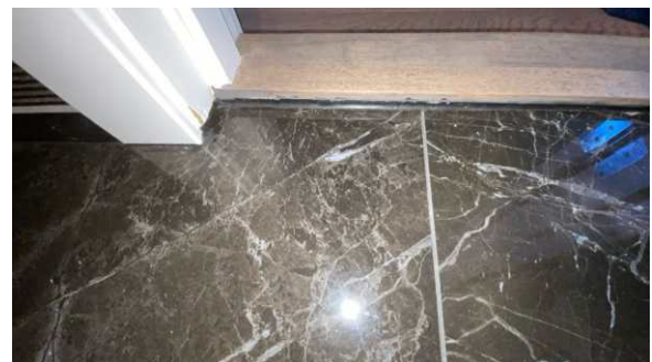
Overgang ved dørterskel.
