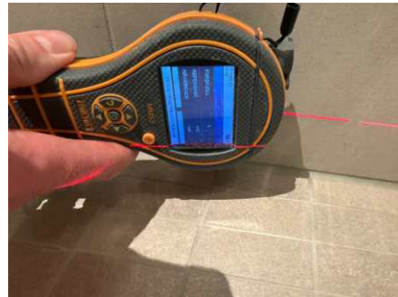
Fuktsøk på overflater.
