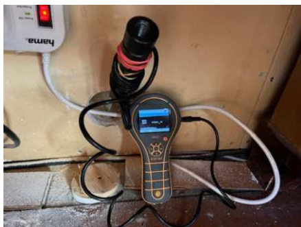
Fuktsøk fra tilstøtende rom- ingen utslag.
