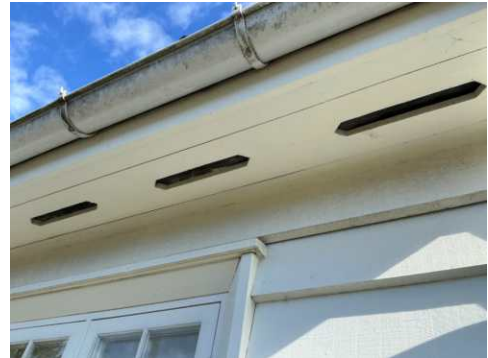
Luftespalter i gesimser
