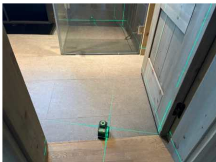
Fall til sluk målt med laser.
