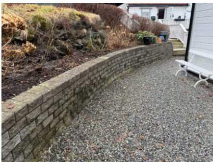
Støttemur ved adkomst mot øst.
