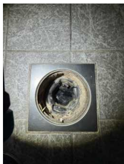
Ikke mulig å verifisere membran i hovedsluk.
