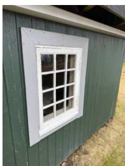
Vinduer i 1-lags glass u oppbevaringsbod under terrasse.
