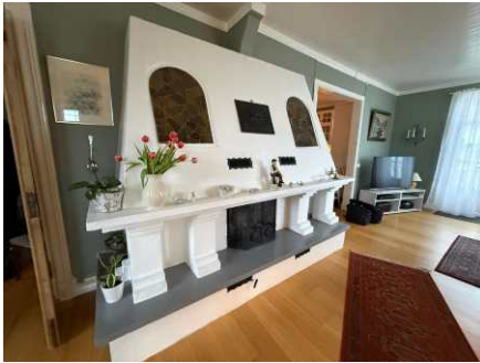
Ildfast plate på gulv anbefales etablert.
