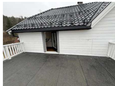
Merk kort gjenværende brukstid på takpapp.
