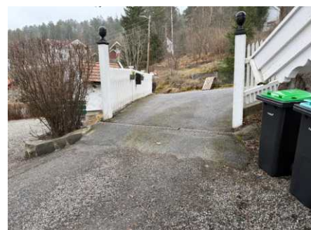
Det er lagt ned et akodren ved innkjøring.
