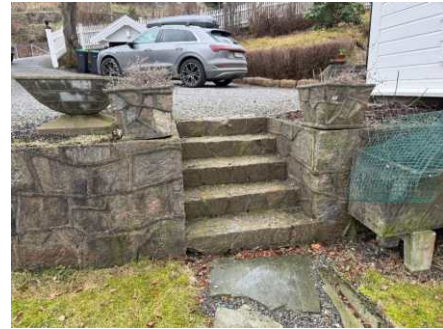
Støttemur ved trapp mot nord.
