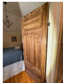
Antikvariske dører fra byggeåret.
