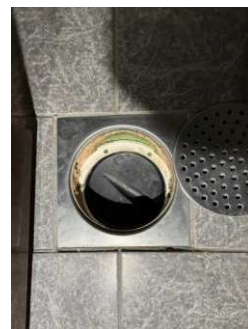
Ikke mulig å verifisere membran i hjelpesluk
