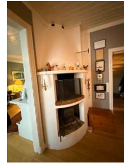
Ildfast plate på gulv anbefales etablert.
