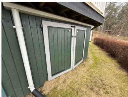
Dør til oppbevaringsplass under terrasse.
