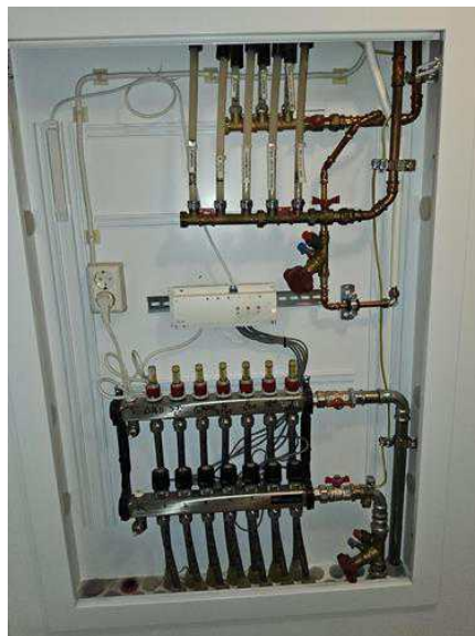
Tekniske anlegg, VVS anlegg (Sjekkpunkter utover det som er inkludert i andre rom) - [Fordeleskap vaskerom/teknisk bod]
