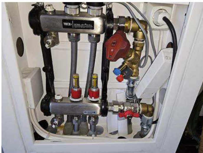
Tekniske anlegg, VVS anlegg (Sjekkpunkter utover det som er inkludert i andre rom) - [Fordelerskap vannbåren varme 5. Etasje ]
