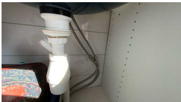
Del av rør til avløp.
