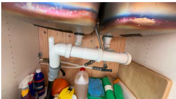
Del av rør til avløp.
