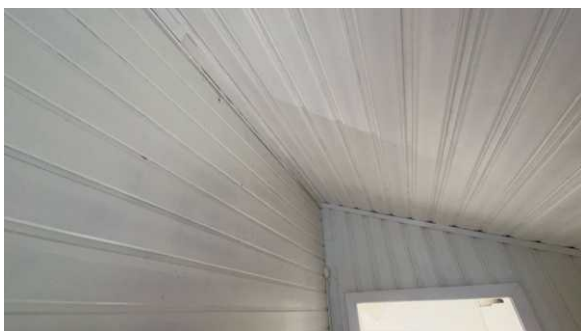
Del av vegg - tak.
