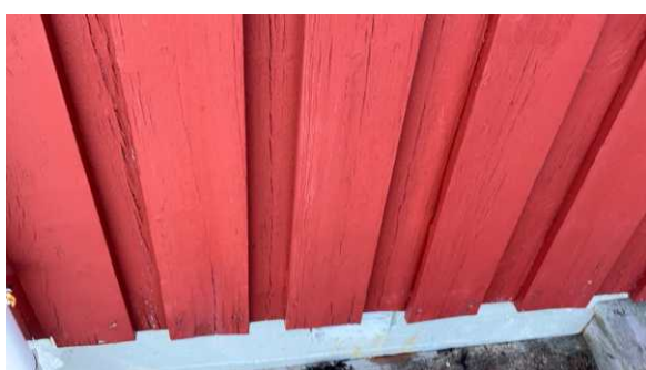
Del av vegg.
