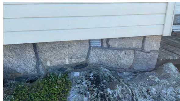
Del av grunnmur.
