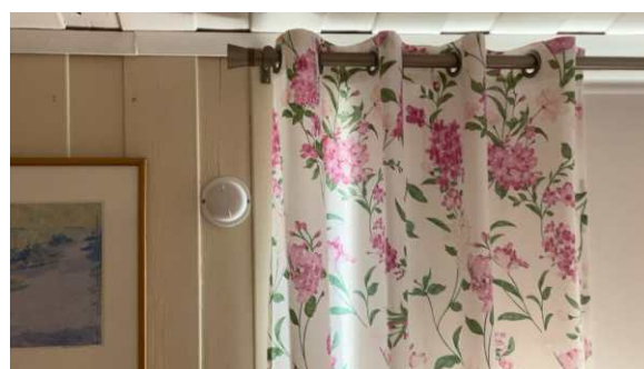
Eksempel på montert ventil i vegg.
