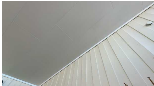
Del av vegg - tak.
