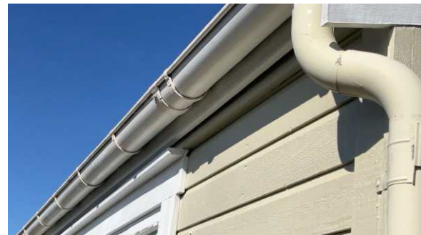
Del av gesims.
