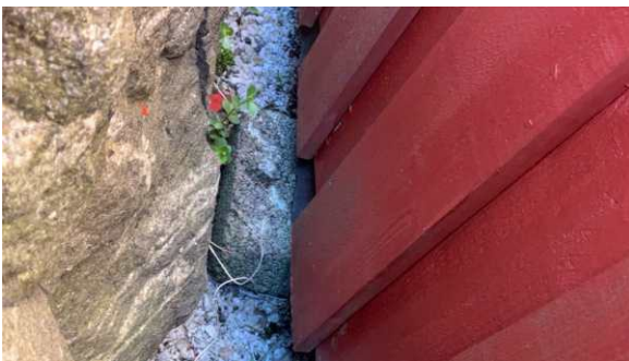
Del av grunnmur.
