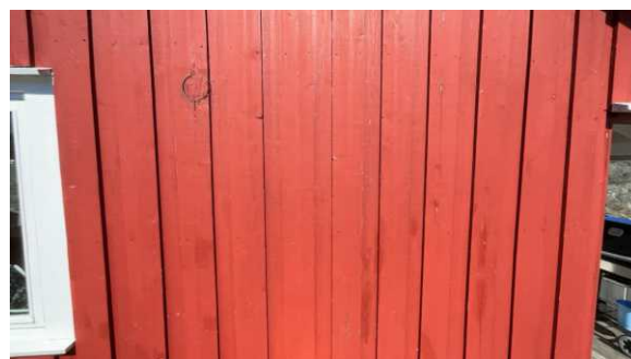
Del av vegg.
