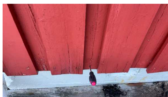
Del av vegg. Stikk kontroll av vegger er utført.
