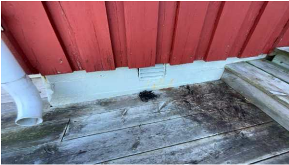
Del av grunnmur.
