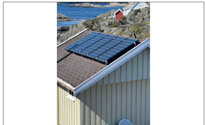
Sol celle til strøm opplegg.
