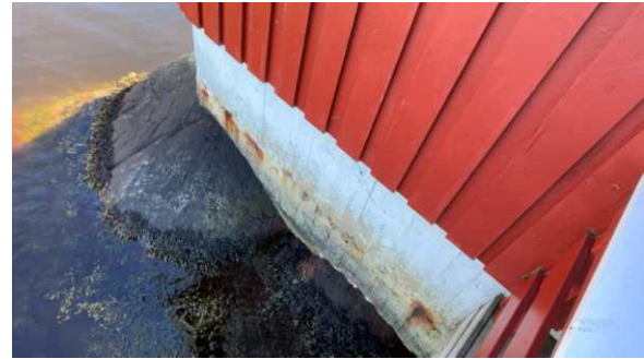
Del av grunnmur.
