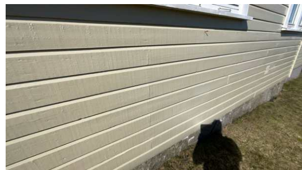
Del av vegg.
