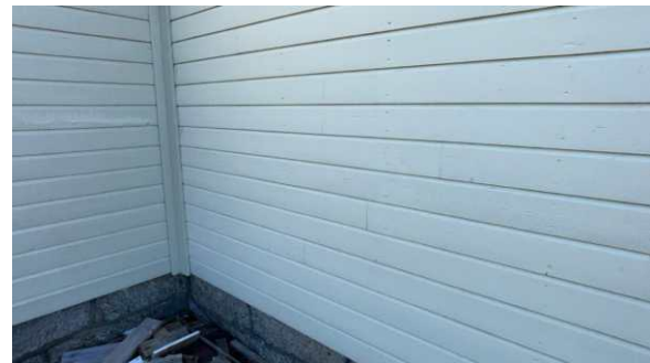
Del av vegg.
