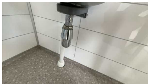
Del av rør til avløp.
