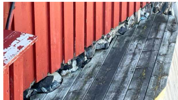
Del av grunnmur.
