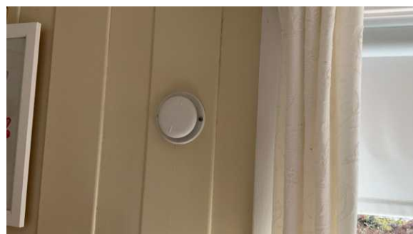
Eksempel på montert ventil i vegg.
