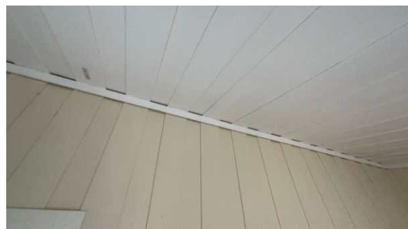
Del av vegg - tak.
