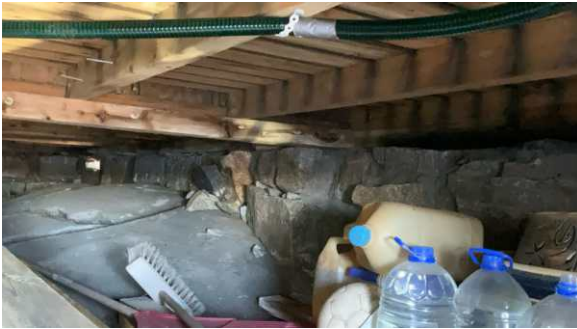
Del av grunnmur.
