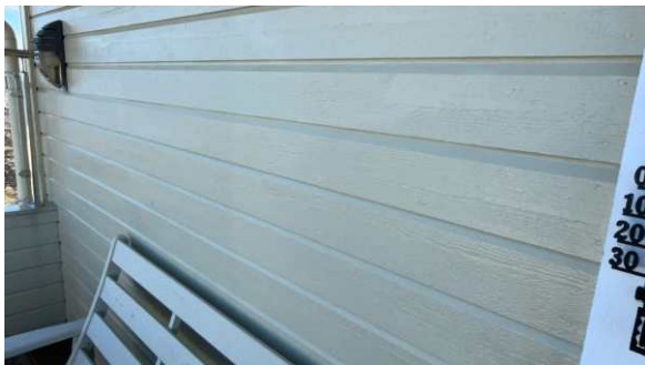
Del av vegg.
