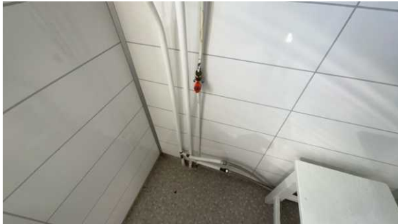
Del av rør til vann.
