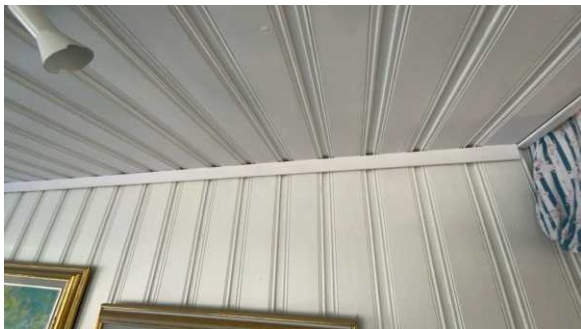
Del av vegg - tak.
