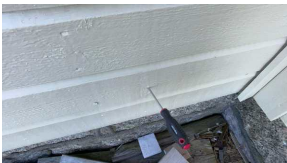
Stikk kontroll av vegger er utført.
