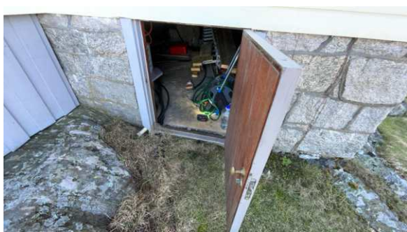
Luke inn til krypkjeller.
