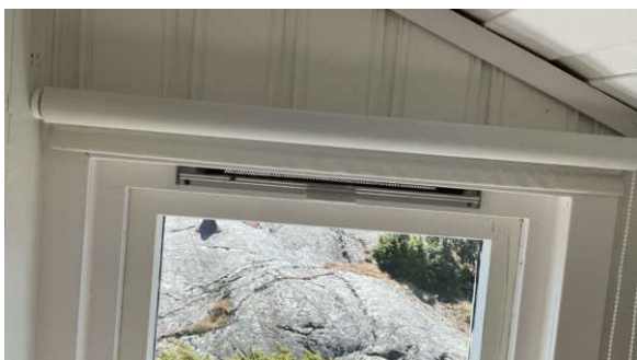
Eksempel på montert ventil i vindu.
