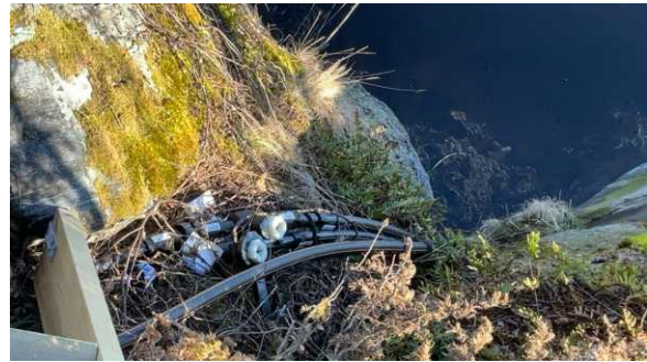
Kommunalt vann og avløp er klargjort inn på eiendommen.
