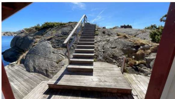
Trapp fra terrasse til terreng.
