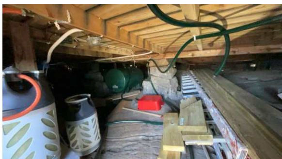
Del av krypkjeller.
