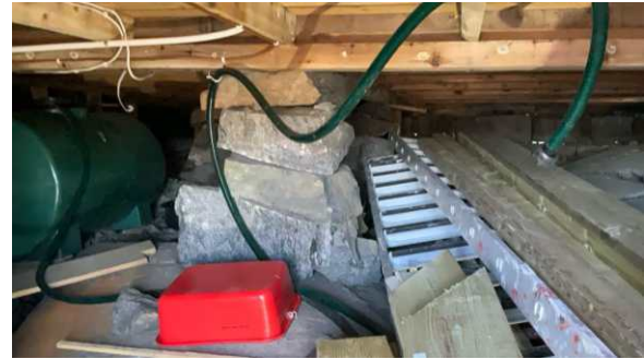
Del av grunnmur.
