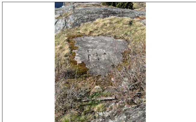
Lokk til brønn.
