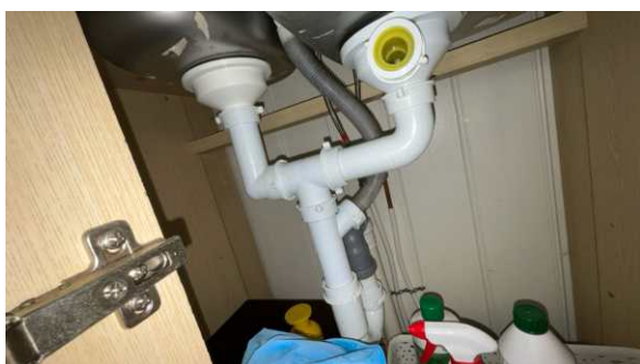
Del av rør til avløp.
