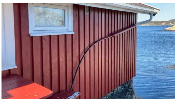
Del av vegg.
