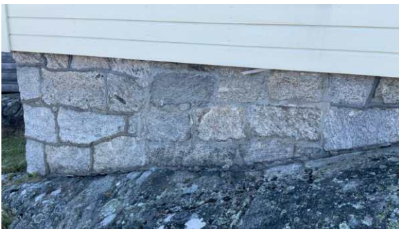
Del av grunnmur.
