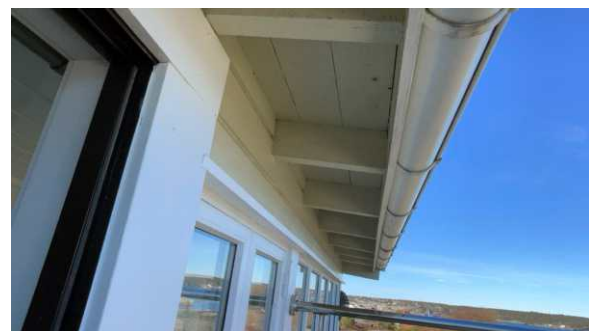
Del av gesims.
