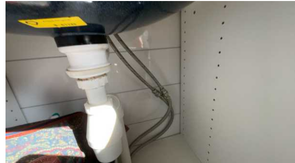
Del av rør til vann.
