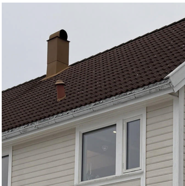
Flassing på takfotbeslag
