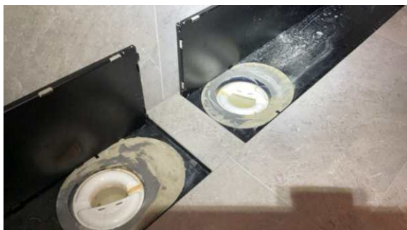
Kontroll av sluk
