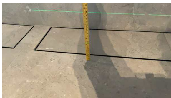
Målt fall til sluk: 31mm
