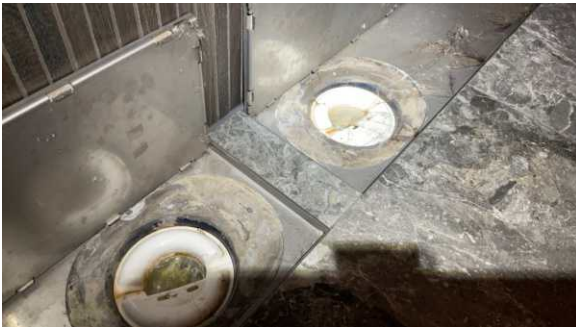
Kontroll av sluk.
