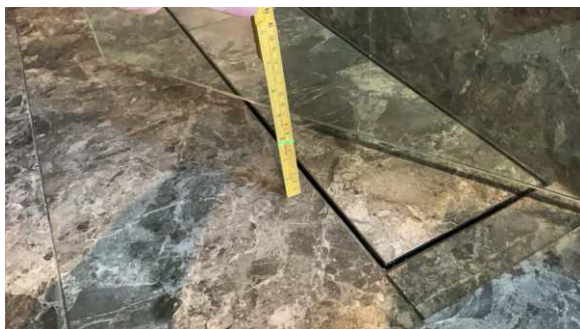
Målt fall til sluk: 19mm.
