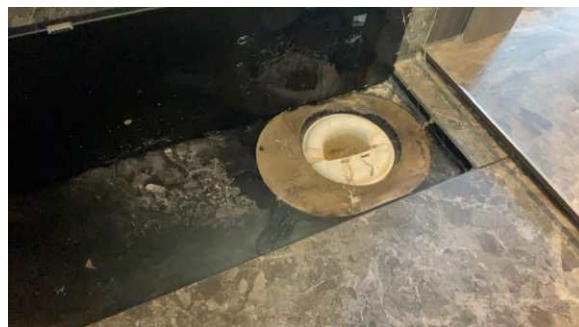
Kontroll av sluk.
