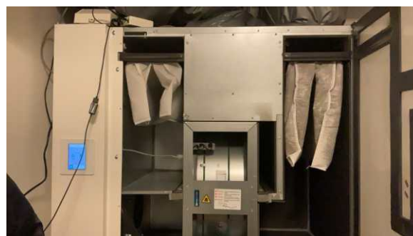
Villavent VTR 500 L balansert ventilasjonsanlegg
