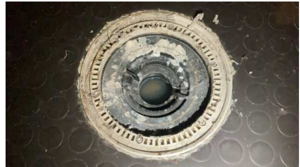
Plastsluk i dusjhjørnet.
