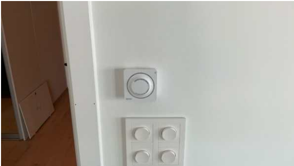
Termostatstyrt gulvvarme.
