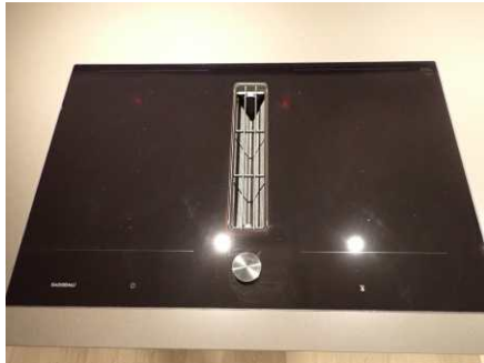
Ventilator nedfelt i koketoppen
