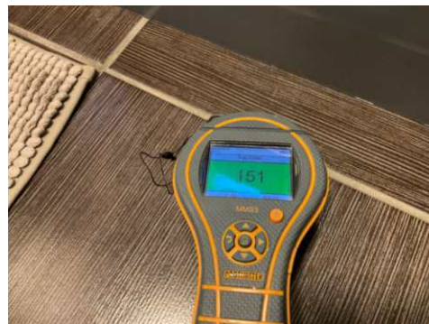
UNDERETASJE > ANNET VÅTROM (DUSJROM)
