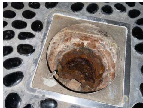
UNDERETASJE > ANNET VÅTROM (DUSJROM)
