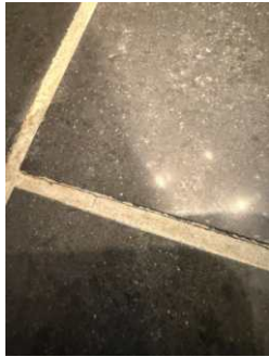
Riss i fuger rundt fliser med bom/hullyd.
