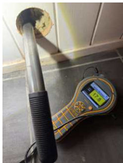
Måling etter fukt i vegg mot bad.
