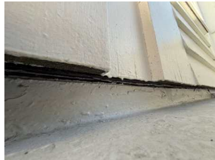
Overgang blekk mot vegg på balkong.
