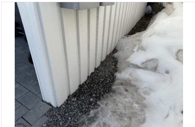
Vegger ligger nedtil terreng.
