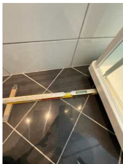
Riss i fuger rundt fliser med bom/hullyd.
