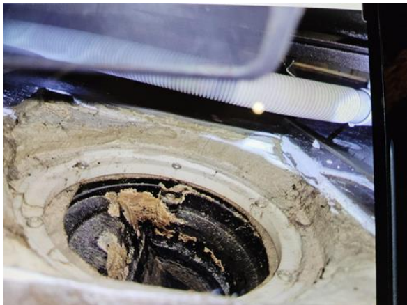
Avløpsrør (ink. sluk) - [Sluk bad]
