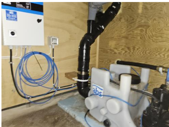
Tekniske anlegg, VVS anlegg (Sjekkpunkter utover det som er inkludert i andre rom) - [Kvernpumpe]
