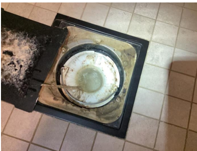
Kontroll av sluk.
