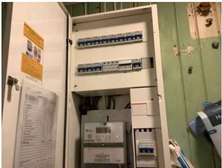
El-anlegg med automatsikringer. I hovedsak åpent ledningsnett. Sikringsskapet er plassert i trapperom ned til kjeller.
