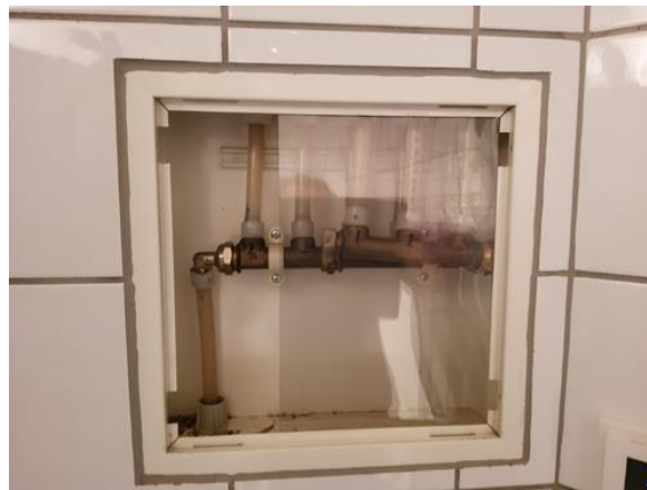
Tekniske anlegg, VVS anlegg (Sjekkpunkter utover det som er inkludert i andre rom) - [Vannskap]
